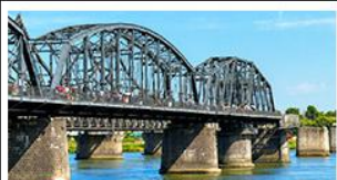
สะพานหวาดถานตง
